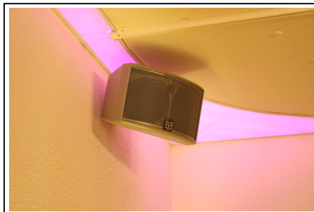
Dezente Integration: Die MartinAudio AQ5 mit 120° Abstrahlwinkel ist die ideale Lösung für schwierige Bereiche
